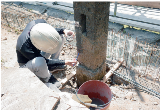
控柱の補修作業（2019年8月2日撮影）
