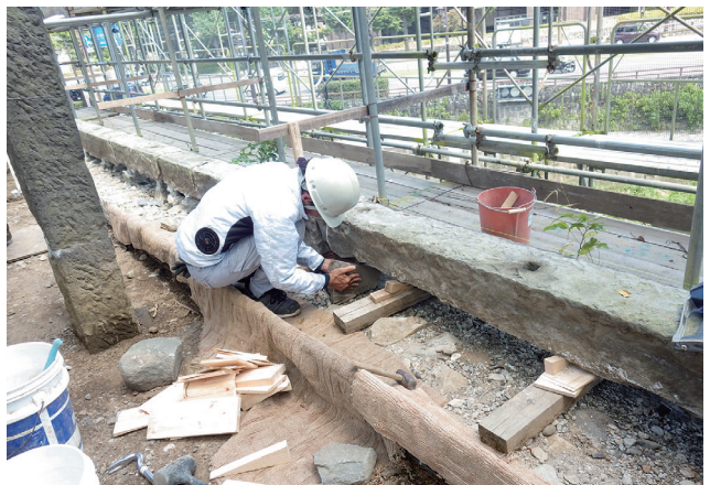
塀基礎石設置作業（2019年8月8日撮影）
